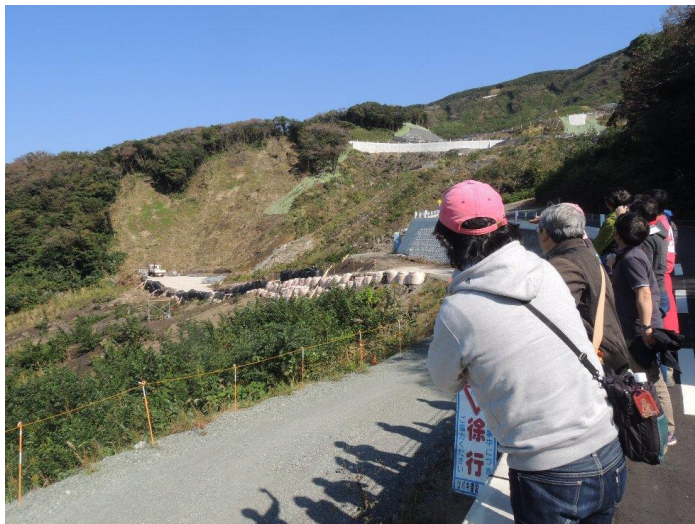
今年は神達散策コースを追加。通行止めが解除された御神火スカイラインを通りました。写真は土砂崩れを起こした三原山の中腹。
