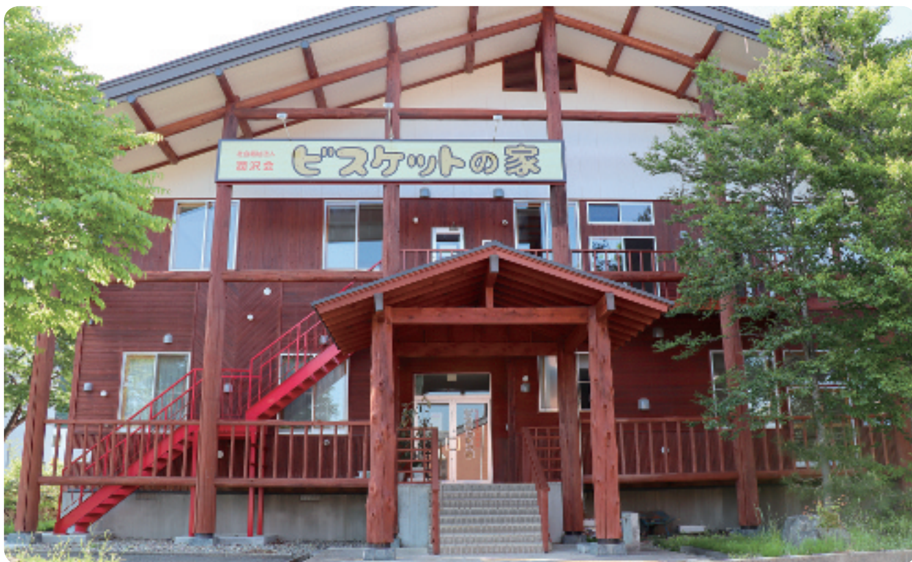
ビスケットの家。元気一番館。長く放置されていた元営林署の空き家を改築した。
