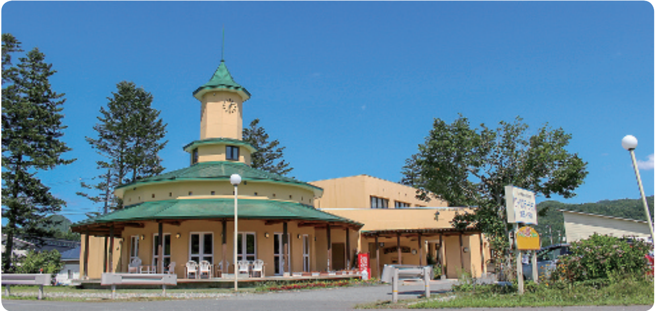
ワークステーション湯田・沢内の外観。
