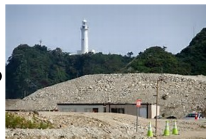
塩屋崎灯台と復旧工事の続く沿岸部
