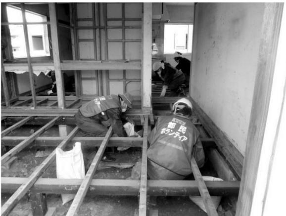
この頃、床上の泥撤去が進み、床下の泥を撤去するニーズも多くなっていた。床板をはずして行う作業で、ケガに注意しつつ行った。
